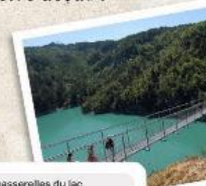
Les passerelles du lac de Monteynard
