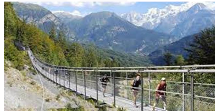
Passerelle de Passy (74)
